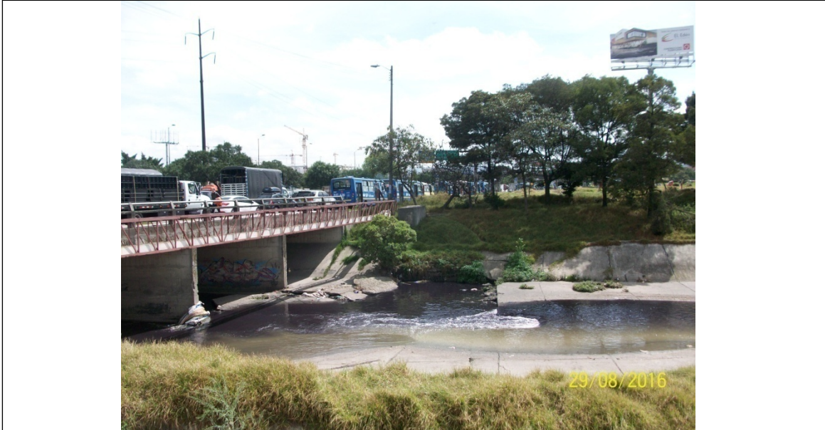
Foto 1. Box Coulvert existente sobre el Canal del río Fucha con avenida Boyacá. Fuente: SDA - SCASP, 2016.
