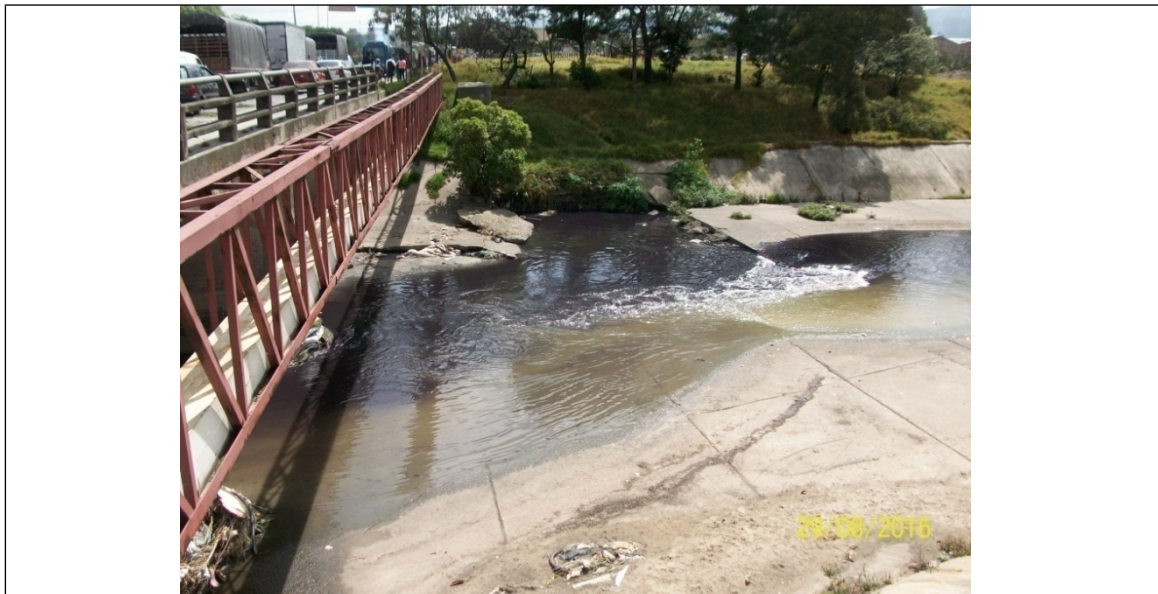
Foto 3. Box Coulvert existente sobre el Canal del río Fucha con avenida Boyacá. Fuente: SDA - SCASP, 2016.
